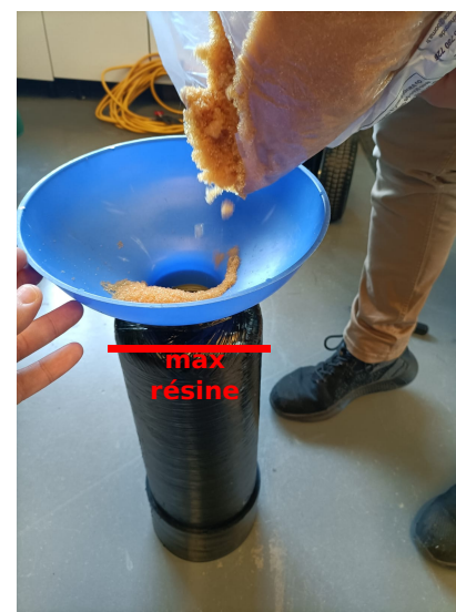
10 - Remplissez la bombonne avec la nouvelle résine jusqu'à 6 cm du bord
