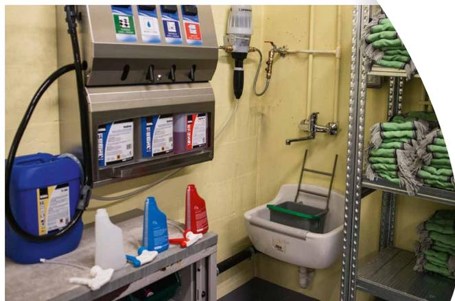
Notre service technique installe un système de dosage BOMAX résistant aux chocs, dans une armoire verrouillable en acier inoxydable, et ce, sur mesure avec votre projet.
